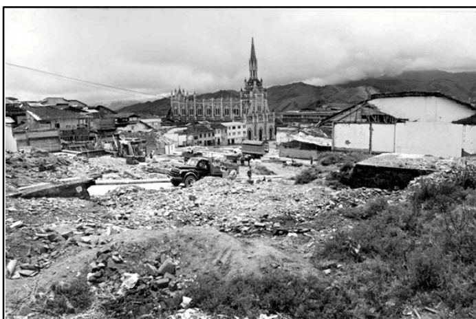
Foto 1. Destrucción de las Manzanas por el trazado en diagonal de la Avenida Gilberto Alzate Avendaño, entre la Iglesia de los Agustinos y el Parque Olaya Herrera. Fuente: INVAMA.
